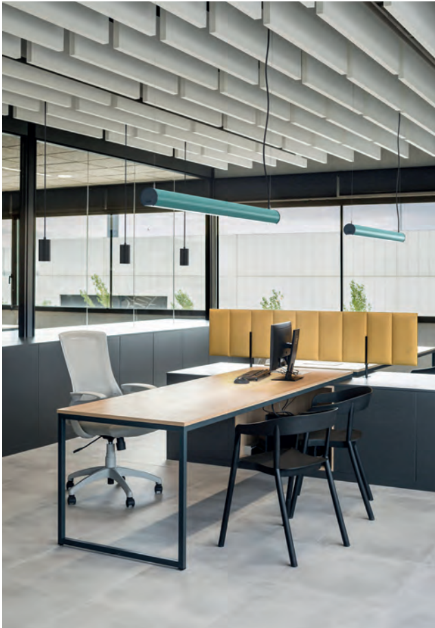
Espacios con instalaciones ocultas (falso techo de lamas acústicas).
