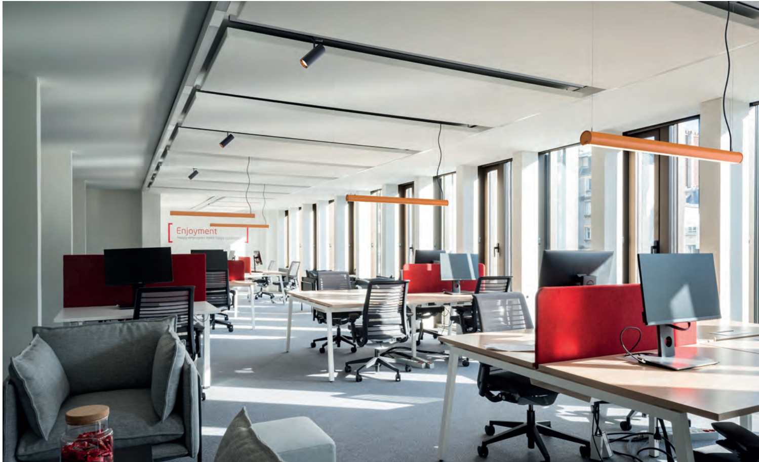
Espacios con instalaciones semi-ocultas (Paneles acústicos de gran formato).
